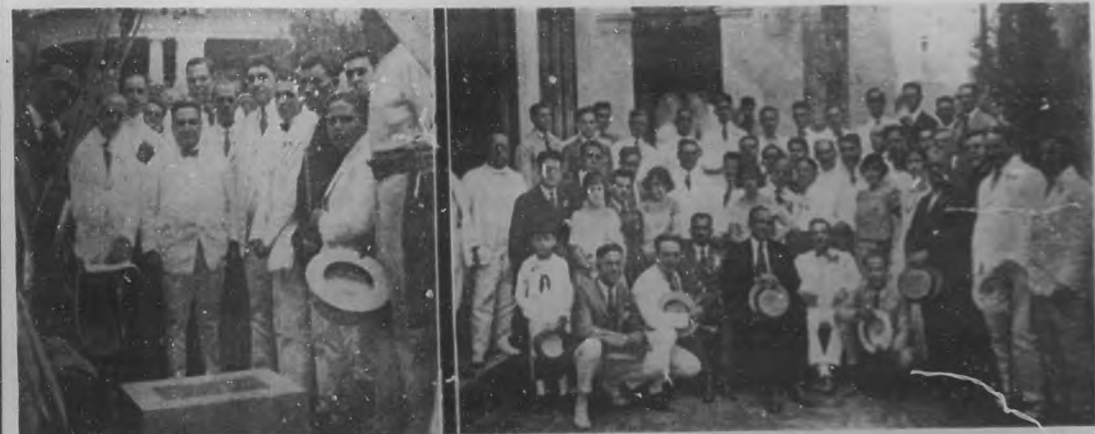
EL PARQUE "LAWTON"—Momento en que era colocada la primera piedra del referido parque.—El Alcalde de la Habana rodeado de un grupo de personas distinguidas que concurren a la ceremonia de la colocación de la primera piedra del parque "Lawton".
